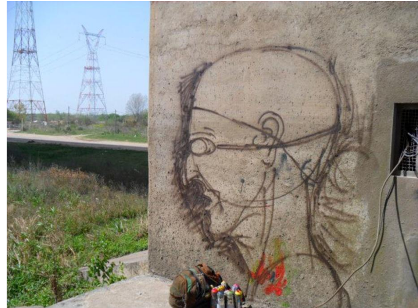
4.Registro del módulo práctico. Proceso: figura de una alumna sobre los cimientos de un puente. Localidad de Zárate, Provincia de Buenos Aires.
