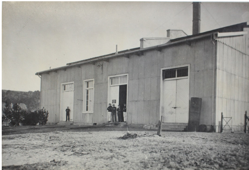
63 Elektrizitätswerke [Planta eléctrica]
