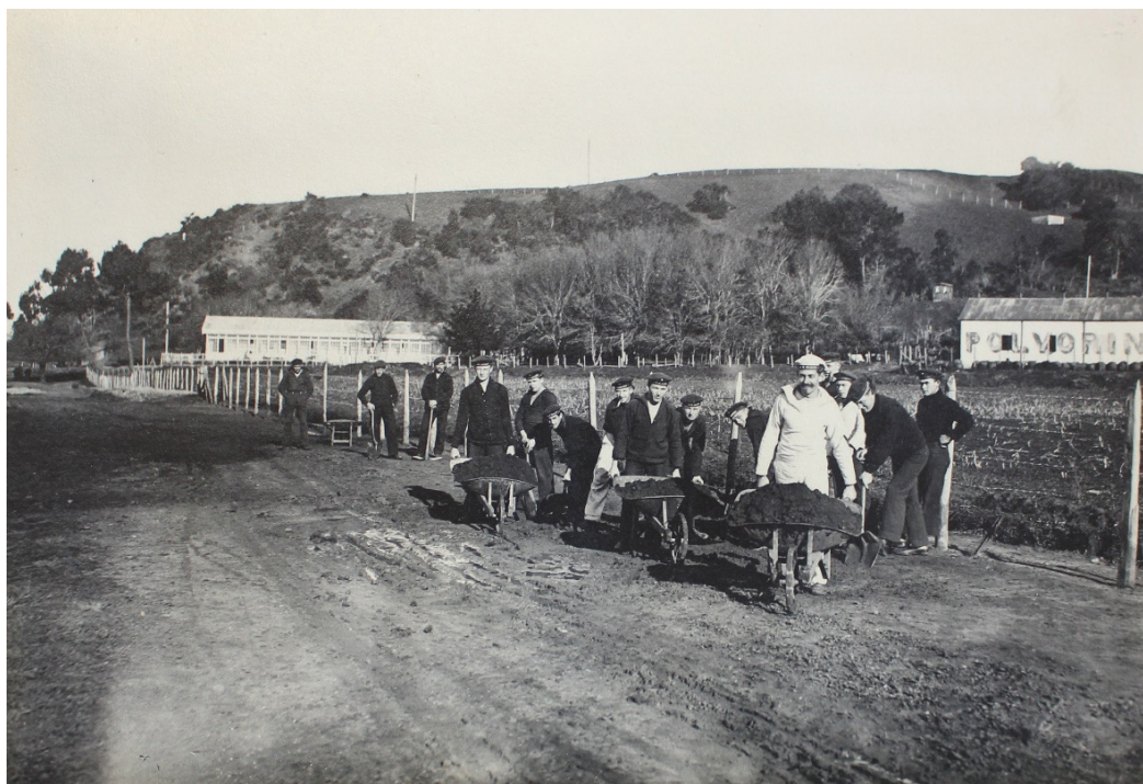
60 Bei Wegebau [Construcción de un camino]
