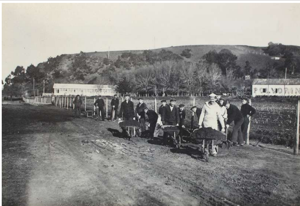
60 Bei Wegebau [Construcción de un camino]
